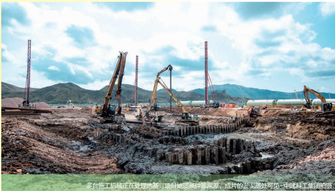
多台施工机械正在处理地基，项目地质条件非常差，成片的淤泥随处可见-中建科工集团拍摄
