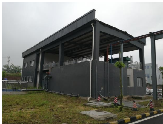
图 4.1-2 公司污水处理站
