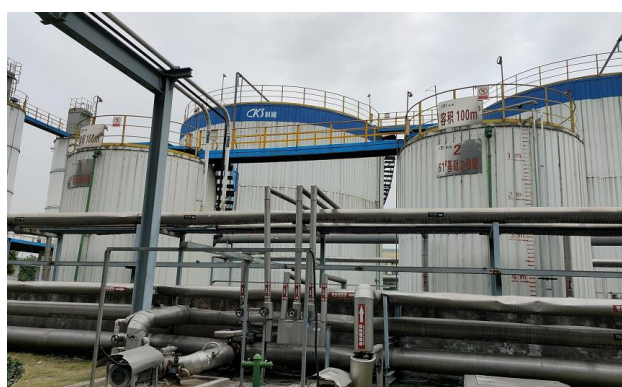
图 4.1-8 基础油储罐围堰
