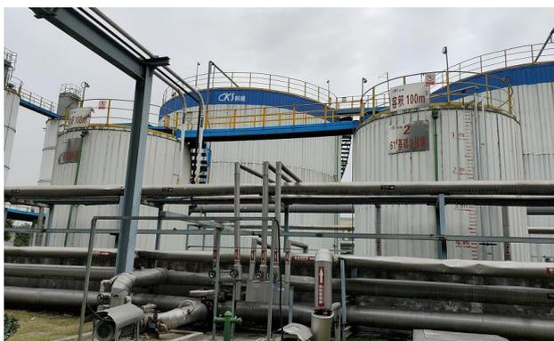
图 4.1-5 基础油储罐围堰
